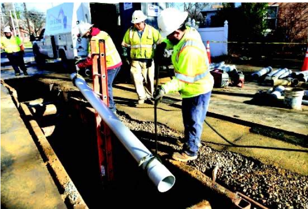
STEP 4: CONDUIT/MANHOLE INSTALLATION
