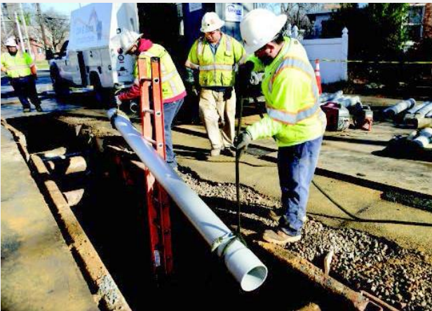
STEP 4: CONDUIT/MANHOLE INSTALLATION
